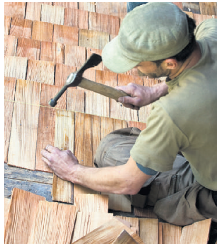
L'anselle, ou bardeau. Tuile d'épicéa, de sapin, de mélèze ou de châtaignier, d'environ 60 cm sur 20 cm, plus épaisse que le taviillon. Adaptées aux toitures à faible pente, les anselles se posent bord à bord.
