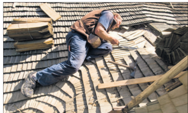
Le taviillon. Tuile de bois d'épicéa d'environ 45 cm de long pour 10 à 15 cm de large. Convient pour les toits en forte pente et les façades. Il en faut 12 couches pour réaliser les 9 cm d'épaisseur d'une couverture.
