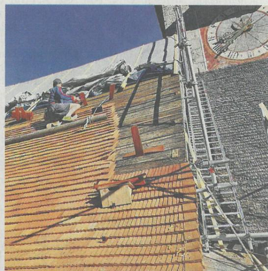
**Luftig.** Dachdecker befestigt in schwindelerregender Höhe die Schindeln mit Nägeln.
