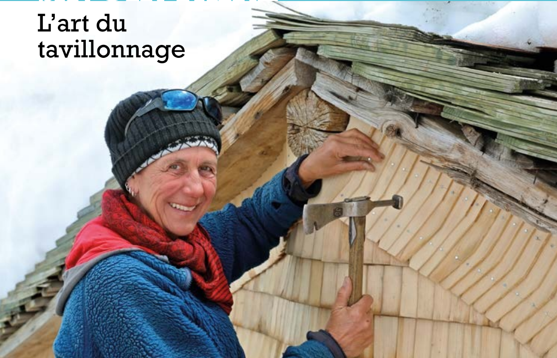
Marjolein Schärer et son équipe se sont attelés à refaire les toits et façades abîmées.
